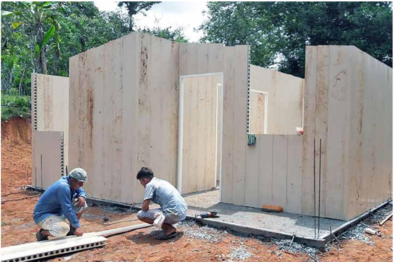
Las obras se construyen con material RBS (formaletas termoplásticas vaciadas en concreto armado) y PCH (paneles de concreto).
