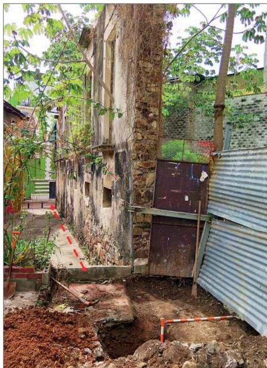
Figura 7. En primer plano la excavación del cimiento de la contramuralla de Hernández en la finca 609, visto desde el Oeste. La línea roja segmentada indica la pared Norte de la finca 1958 que también se apoya sobre el cimiento, en el callejón Salvador Durán, y al fondo está la calle 11 Oeste (fotografía por Tomás Mendizábal).
