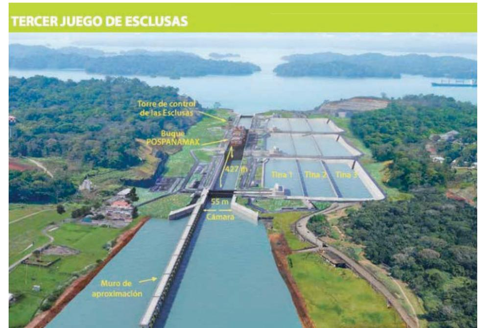
*El proyecto se encargó del diseño y la construcción de dos complejos similares de esclusas, uno en el Pacífico y otro en el Atlántico. Cada uno con tres cámaras, nueve tinas de reutilización de agua y un sistema redundante de compuertas rodantes.*
