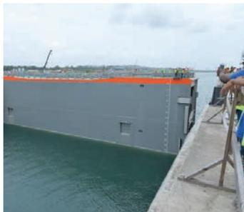
sola "hoja" de compuerta se desplaza a través del ancho completo de la cámara para cerrarla.
