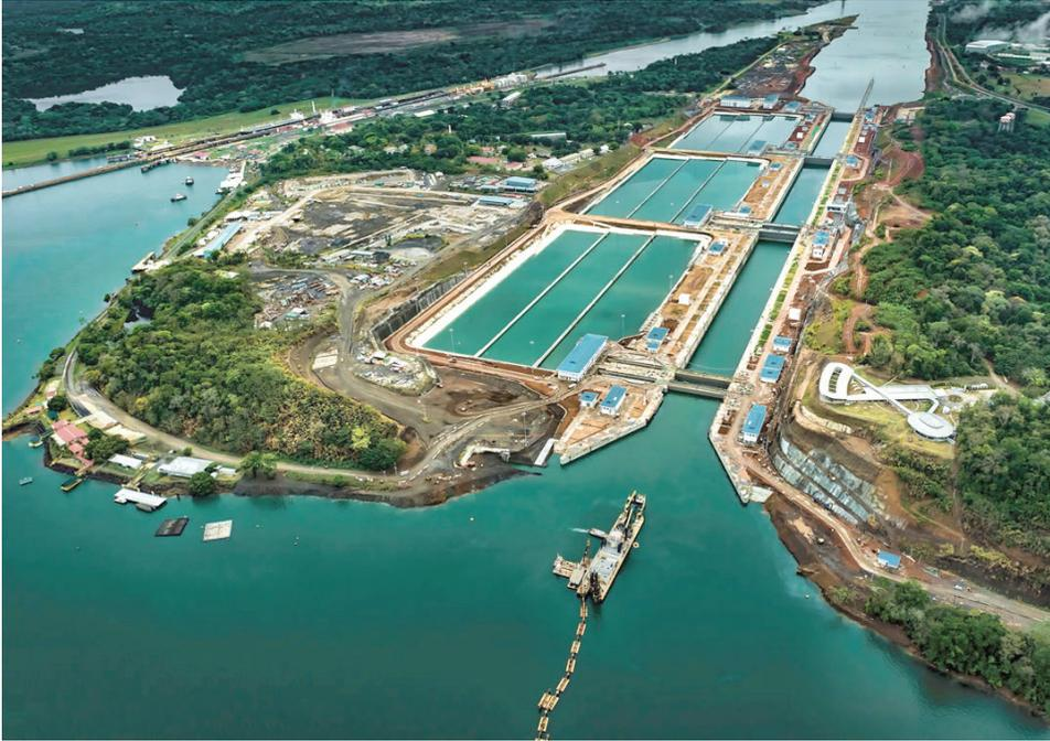
**La ampliación del Canal de Panamá consiste en la construcción de dos complejos de esclusas de tres niveles cada una con tres tinas de reutilización de agua por nivel, una en el lado Pacífico y otra en el lado Atlántico.**
