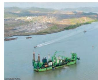
**Dragado en la entrada del Pacífico que consistieron en el ensanche, a un mínimo de 225 metros y la profundización a 15.5 metros por debajo del nivel medio de mareas bajas.**
